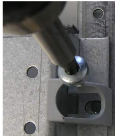
Abb. 22 / Fig. 22 Befestigung des Käfigs Fixing of the cage
