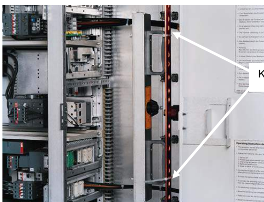
Abb. 23 / Fig. 23 Transportsicherung des Modulgriffes Transport protection of the service handle
