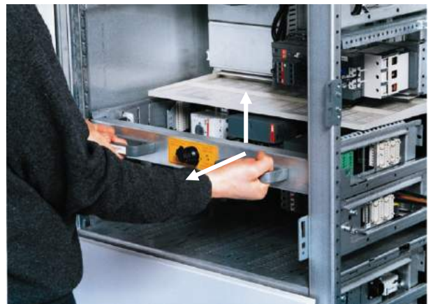
Abb. 58 / Fig. 58 Modul leicht anheben und bis zur ersten Raststellung herausziehen. Modulgriff entriegeln und gleichzeitig das Modul verriegeln. Modulgriff abnehmen. Lift module slightly and pull it out up to the first engaged position. Unlock service handle and lock the module at the same time. Remove service handle.
