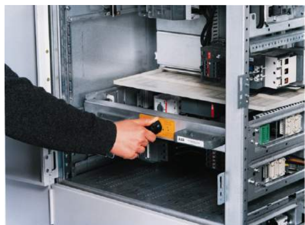
Abb. 80 / Fig. 80 Verriegeln des Modulgriffes bei gleichzeitigem Entriegeln des Moduls. Locking the service handle when simultaneous unlocking the module.
