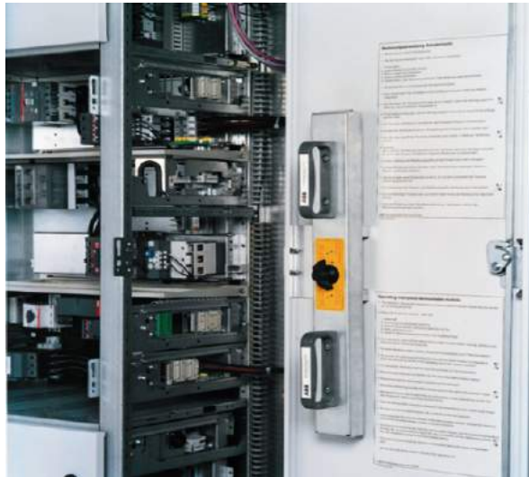
Abb. 78 / Fig. 78 Geöffnete Tür mit Modulgriff und Bedienungsanleitung Open door with service handle and operating instruction
