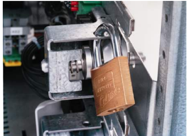
Abb. 61 / Fig. 61 Sicherung des Schubeinsatzmoduls mittels Vorhängeschloss Securing the railable module using a padlock
