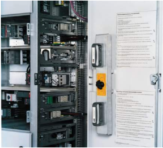
Abb. 55 / Fig. 55 Geöffnete Tür mit Modulgriff und Bedienungsanleitung. Open door with service handle and operating instruction.
