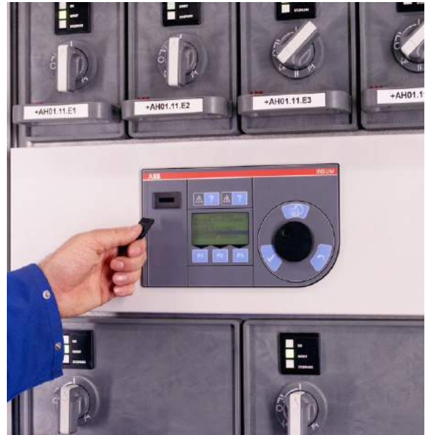
Abb. 65 / Fig. 65 Frontansicht Einschübe 8E/4 und 8E/2 mit INSUM Front view of withdrawable modules size 8E/4 and 8E/2 with INSUM
