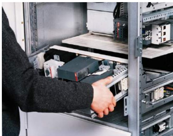
Abb. 82 / Fig. 82 Entnehmen des Moduls Removing the module
