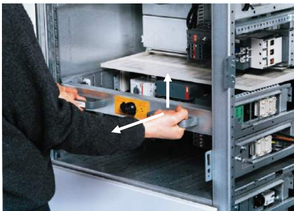
Abb. 81 / Fig. 81 Anheben und Herausziehen des Moduls Lifting and pulling out the module
