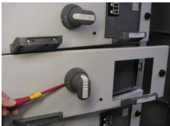
Abb. 84 / Fig. 84 Entriegeln der Modultür eines Einschubes mit Hilfe eines Schrau- bendrehers Unlatching the front cover of a withdrawable module by means of a screw driver
